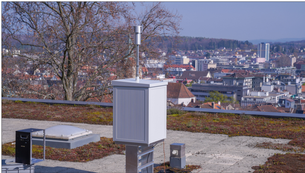
Staziun da mesiraziun dal project «Ally Science», installada a Bienna.
